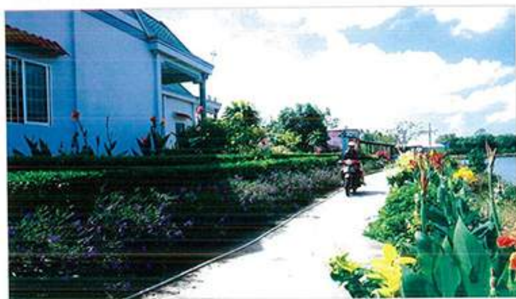
Một phần tuyến đường bê tông ấp Ông Định, xã Tân Ân Tây
