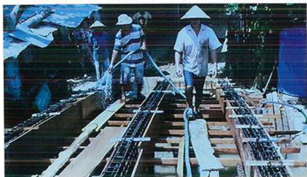
Ông Biện Bá Lợi (người đội nón lá) cùng anh em Đội Cầu đường đang tiến hành thi công cầu nông thôn
