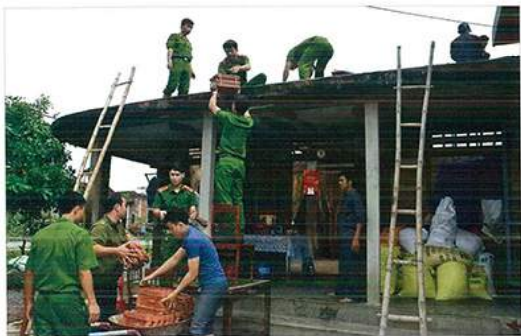
Công an huyện Triệu Phong giúp dân sửa chữa nhà
