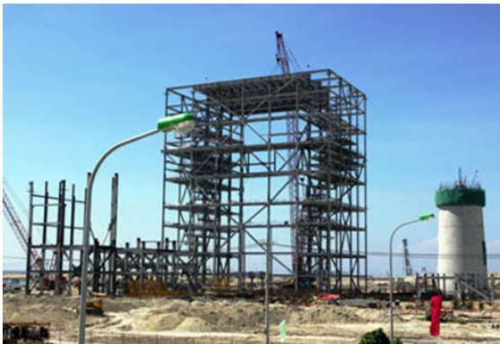
Hạng mục chính nhà máy nhiệt điện Vĩnh Tân 2 đang được khẩn trương thi công. Ảnh: Chinhphu.vn
