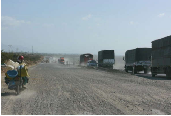
QL1A đoạn đi qua huyện Tuy Phong đang thi công dồn dập nên vô cùng nguy hiểm - Ảnh : N.C.T
