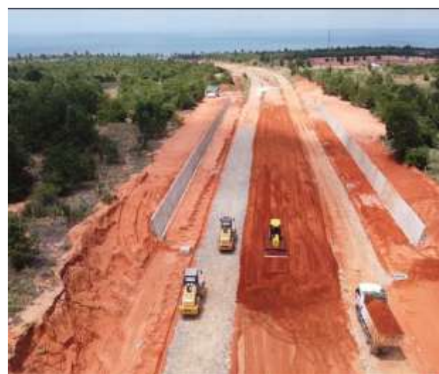
Đoạn đường dẫn vào sân bay Phan Thiết có chiều dài tuyến hơn 3,6 km dự kiến hoàn thành vào quý 3/2021
