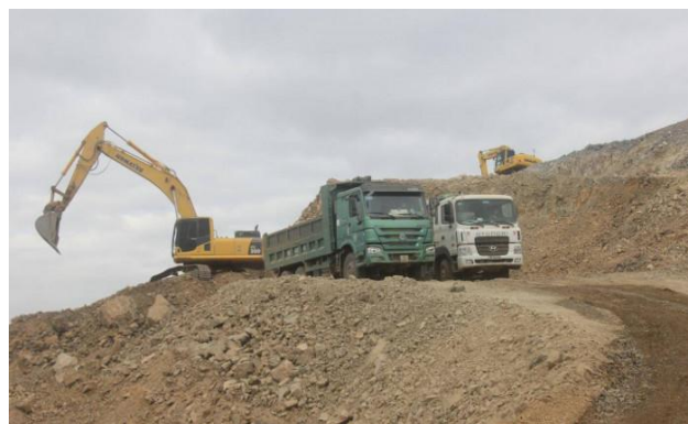
Thi công trên công trường cao tốc Vĩnh Hảo - Phan Thiết.
