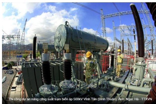
Thi công dự án nâng công suất trạm biến áp 500kV Vĩnh Tân (Bình Thuận). Ảnh: Ngọc Hà - TTXVN
