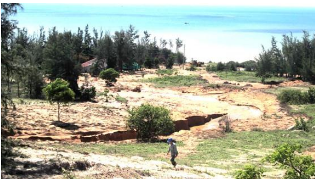
Sự cố vỡ bờ hồ chứa nước thải titan xảy ra tại tỉnh Bình Thuận vào tháng 6-2016
