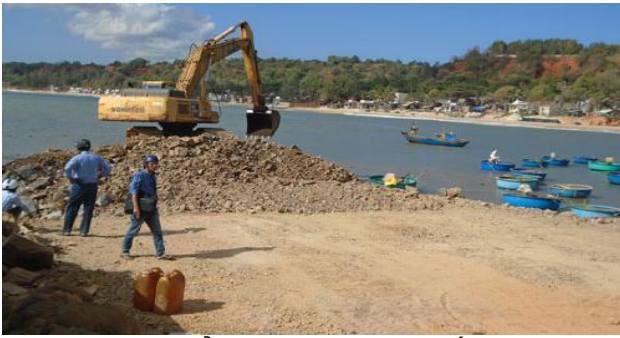
Thi công kè biển đoạn giáp xã Tiến Thành với phường Đức Long, TP Phan Thiết
