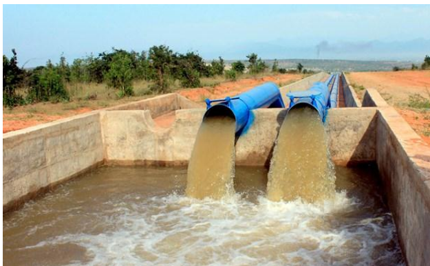
Đưa nước về Chiến Khu Lê phục vụ đồng bào DTTS huyện Bắc Bình (Bình Thuận)
