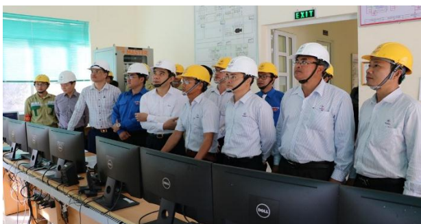
Ông Nguyễn Hữu Tuấn đã ghi nhận và biểu dương những nỗ lực của tập thể cán bộ công nhân viên trạm biến áp 220 kV Hàm Tân, của Truyền tải điện Bình Thuận và Công ty Truyền tải Điện 3 để hoàn thành tốt nhiệm vụ được giao. Ảnh: Đức Dũng/BNEWS/TTXVN
