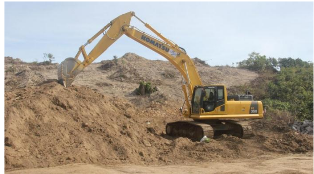
Thi công trên công trường gói thầu XL04 cao tốc Vĩnh Hảo - Phan Thiết.
