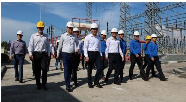
Ông Nguyễn Hữu Tuấn và Đoàn công tác đã đến thăm và làm việc tại trạm biến áp 220 kV Hàm Tân, Truyền tải điện Bình Thuận thuộc Công ty Truyền tải điện 3 (PTC3). Đức Dũng/BNEWS/TTXVN
