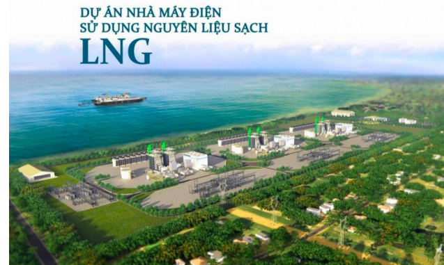
Phối cảnh dự án nhà máy điện khí LNG Mũi Kê Gà với mô hình FSRU
