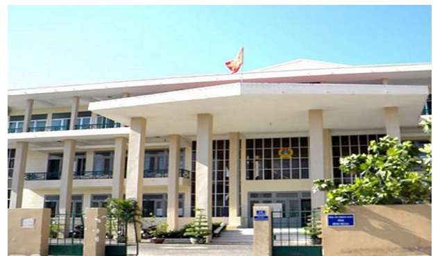
Trụ sở TAND tỉnh Bình Thuận
