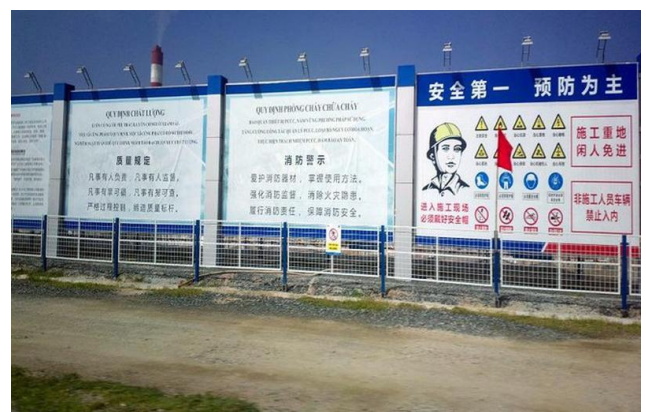
Đường vào Nhà máy nhiệt điện Vĩnh Tân 1
