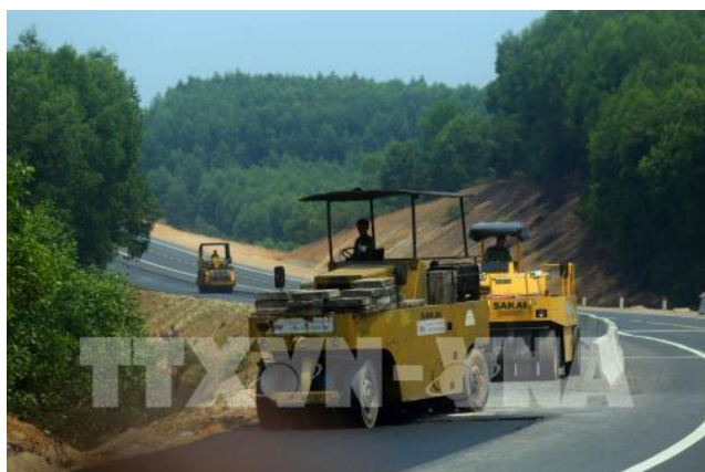
Dự án đường bộ cao tốc Bắc – Nam đoạn qua địa bàn tỉnh Bình Thuận có tổng chiều dài 160 km. Ảnh: Huy Hùng – TTXVN
