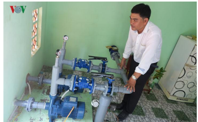
Một số hộ dân trên đảo tận dụng các giếng khoan có sẵn để xây dựng nhà máy cấp nước tư nhân.
