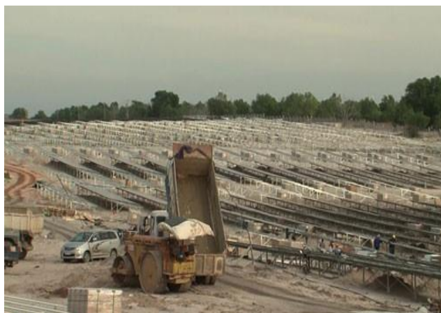
Nhiều dự án điện mặt trời ở Bình Thuận đang chạy nước rút để kịp đóng điện đúng thời hạn hưởng giá ưu đãi
