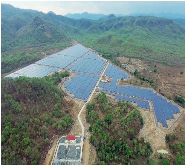
Nhà máy Điện mặt trời TTC - Hàm Phú 2 là Nhà máy Điện mặt trời đầu tiên nối lưới điện 110 kV tại tỉnh Bình Thuận
