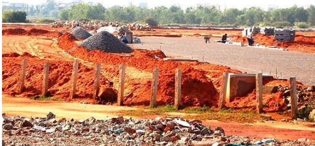
Khu dân cư nông thôn Hàm Thắng - Hàm Liêm giai đoạn 2 của Công ty Nguyên Bình chưa có giấy phép xây dựng nhưng đã ồ ạt thi công hạ tầng, công khai rao bán đất nền
