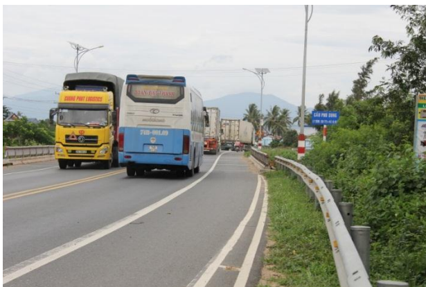
Tuyến QL1 đoạn qua tỉnh Bình Thuận nhiều đoạn đã quá tải.
