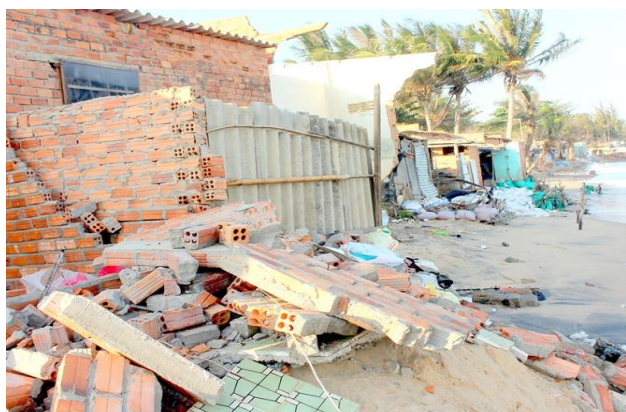
Sạt lở tại thôn Tiến Đức, xã Tiến Thành, TP Phan Thiết
