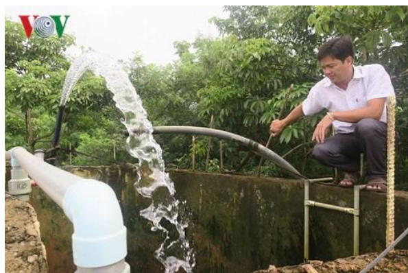
Nước thô được đưa vào hồ chứa để xử lý.
