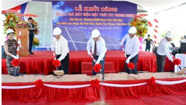
Lễ khởi công xây dựng Nhà máy điện mặt trời Tuy Phong.
