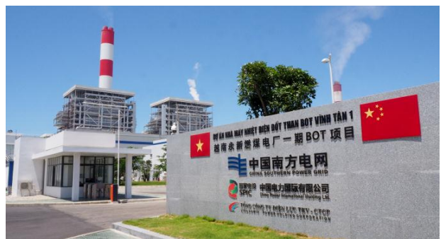
Dự án nhà máy nhiệt điện đốt than BOT Vĩnh Tân 1.
