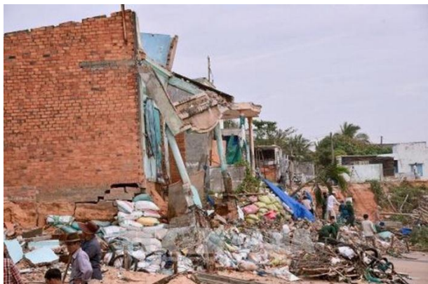
Biển xâm thực đã gây sạt lở nghiêm trọng bờ biển và đánh sập hoàn toàn nhiều căn nhà của người dân tại xã Tiến Thành, thành phố Phan Thiết
