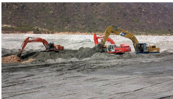
Bãi tro xỉ của Nhà máy Nhiệt điện Vĩnh Tân 2
