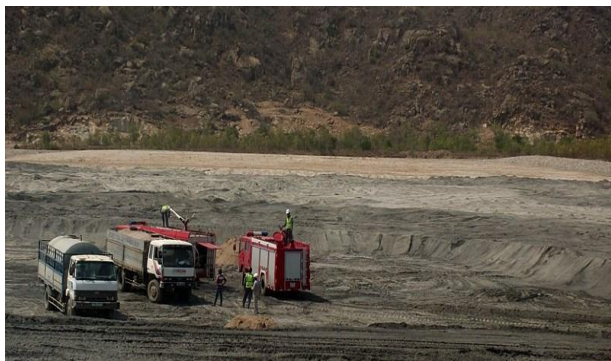
Bãi xỉ Nhà máy nhiệt điện Vĩnh Tân 2 đã chứa gần 50% công suất.
