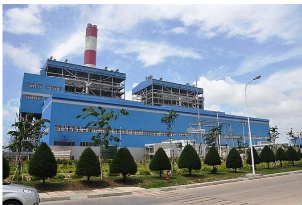
Trung tâm điều hành Nhà máy Nhiệt điện Vĩnh Tân 2
