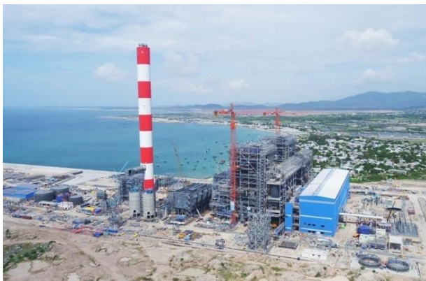
Dự án Nhiệt điện Vĩnh Tân I tại huyện Tuy Phong, tỉnh Bình Thuận
