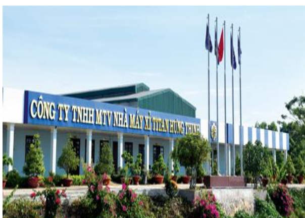
Nhà máy xử titan Hưng Thịnh. Ảnh: Phạm Duy
