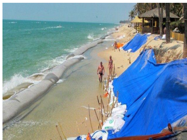
Bờ biển nham nhở các loại kè do chủ các resort tự ý xây dựng, du khách gặp rất nhiều khó khăn khi tắm biển.
