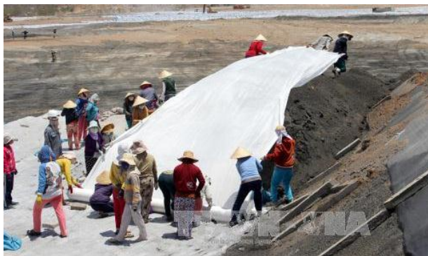
Phủ bạt lên bãi xỉ để khắc phục ô nhiễm tại Nhà máy nhiệt điện Vĩnh Tân 2.
