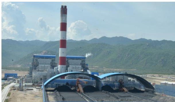
Nhà máy nhiệt điện Vĩnh Tân 2. Ảnh: VGP/Toàn Thắng
