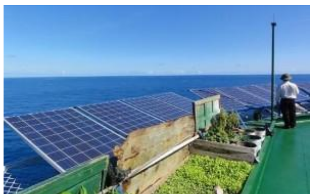
Dự án Nhà máy điện mặt trời Sông Lũy 1 sẽ được xây dựng tại tỉnh Bình Thuận (Ảnh minh họa)
