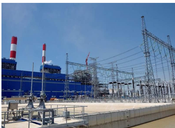
Nhà máy nhiệt điện Vĩnh Tân 4.
