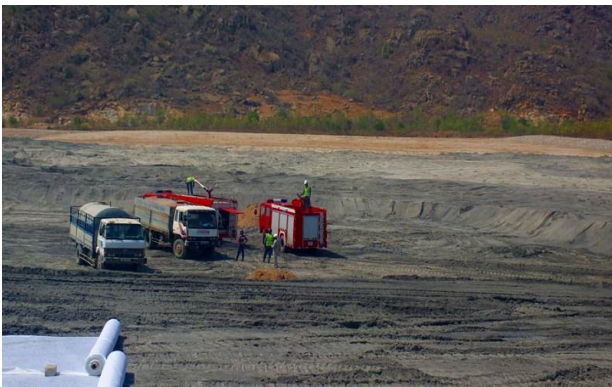
Bãi xỉ Nhà máy nhiệt điện Vĩnh Tân 2
