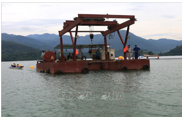
Thả thiết bị neo hệ thống phao chứa pin mặt trời của nhà máy điện mặt trời nổi trên hồ thủy điện Đa Mi.
