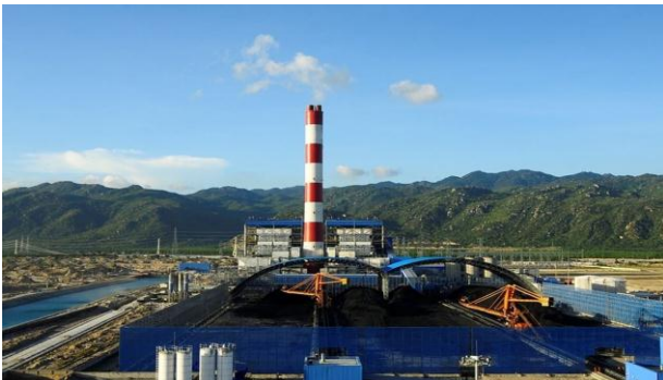
Áp lực từ triệu tấn tro xỉ
