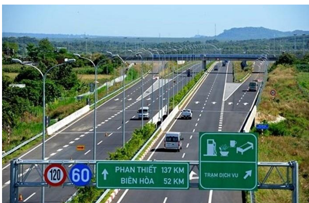
Tháng 7/2020 khởi công cao tốc Phan Thiết - Dầu Giây
