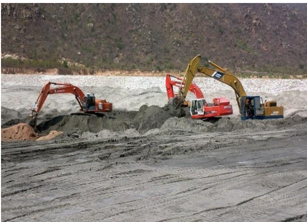
Bãi xỉ đang sắp quá tải tại Vĩnh Tân.
