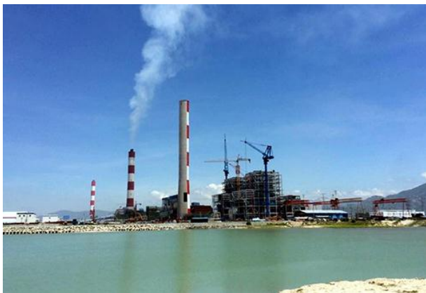
Vũng quay tàu trước nhà máy Vĩnh Tân 1. Ảnh: Phước Tuấn/Vnexpress.
