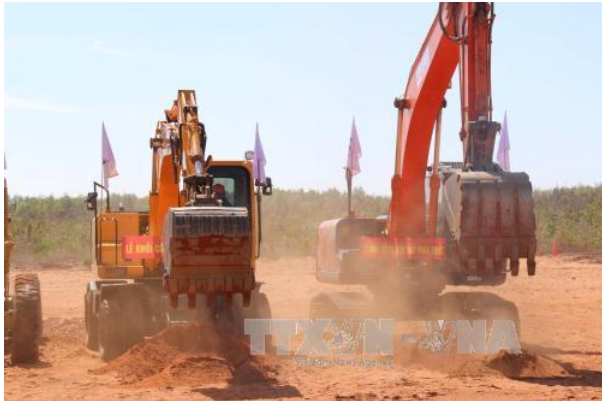
Các phương tiện thi công động thổ, khởi công xây dựng sân bay Phan Thiết.
