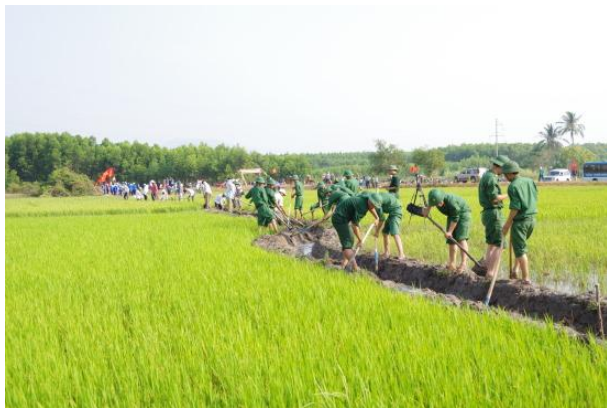
Cán bộ, chiến sỹ BĐBP Bình Thuận tham gia nạo vét, gia cố hệ thống kênh mương nội đồng tại thôn Phò Trì, xã Tân Thắng, huyện Hàm Tân. Ảnh: Đinh Phú
