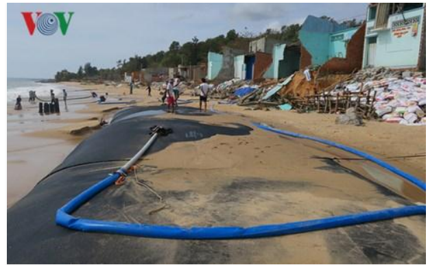
Công trình kè tạm dài 500m bằng công nghệ vải địa kỹ thuật đang được thi công để bảo vệ làng chài Tiến Đức, TP Phan Thiết, tỉnh Bình Thuận
