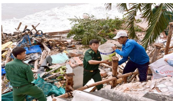
Cán bộ, chiến sĩ Bộ CHQS tỉnh Bình Thuận, BDBP tỉnh giúp dân thôn Tiến Đức, xã Tiến Thành, TP Phan Thiết gia cố bờ biển bị sạt lở.
