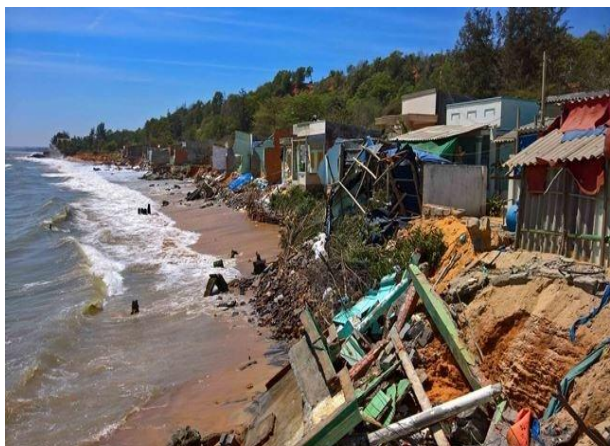
Hơn 1.000 m bờ biển xã Tiến Thành, TP Phan Thiết bị sạt lở.
