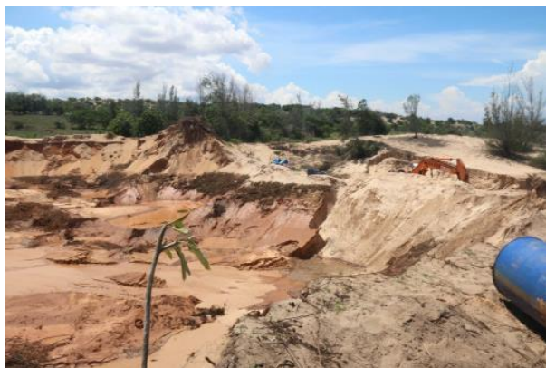
Đoàn công tác Tổng cục Địa chất và khoáng sản Việt Nam đến kiểm tra thực tế hiện trường vụ vỡ hồ chứa nước đãi titan tại xã Thuận Quý, huyện Hàm Thuận Nam (Bình Thuận) hồi tháng 6/2016. Ảnh: Nguyễn Thanh - TTXVN
