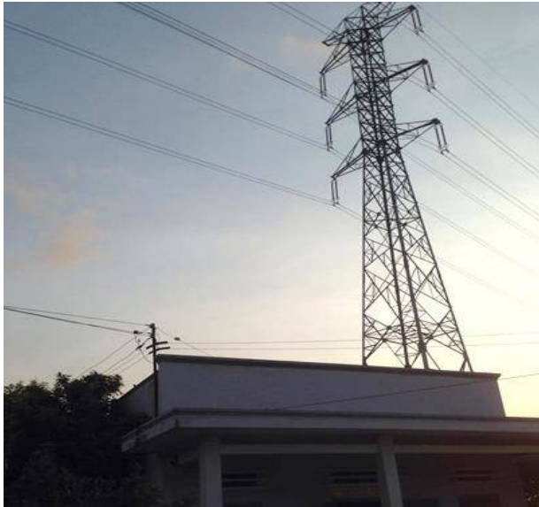
Nhà ông Chín nằm ngay dưới đường dây 220KV.
