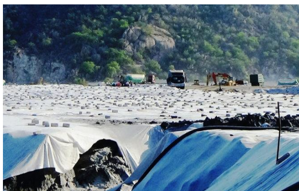
Bãi xỉ thải của Nhà máy nhiệt điện Vĩnh Tân 2 hiện đang được xử lý bằng cách nén và chôn lấp tạm thời tro xỉ. Sắp tới lượng tro xỉ than này sẽ được dùng sản xuất gạch - Ảnh: Ng.Nam
