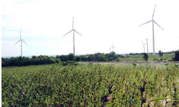
Nhà máy Điện gió Phú Lạc sắp hoạt động, hòa lưới điện quốc gia Ảnh: Minh Hải
