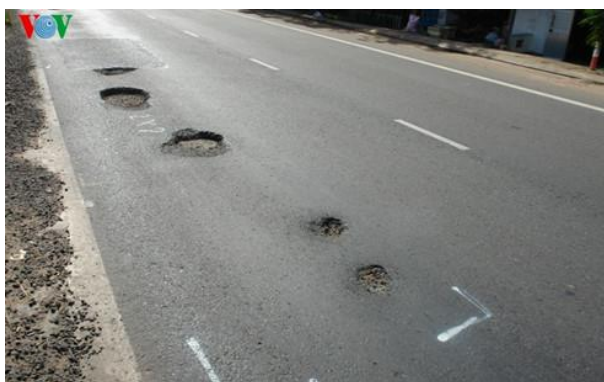
Ổ gà gây nên bởi xe tải, xe ben quá tải chạy tốc độ cao, gây nguy hiểm cho người đi đường. (Ảnh: Việt Quốc)
