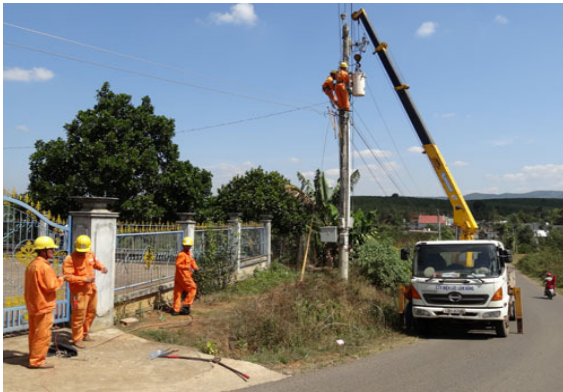
Nâng cấp hệ thống lưới điện tại Bình Thuận
