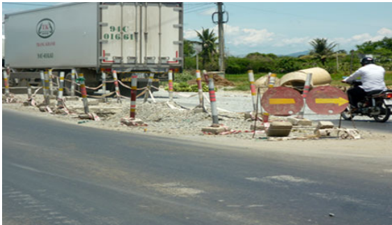
Dự án nâng cấp mở rộng QL1A đoạn qua tỉnh Bình Thuận.
