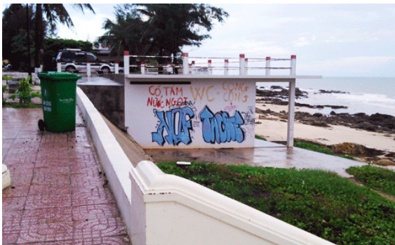
Nhà tắm, nhà vệ sinh cũng xây trên bãi biển
