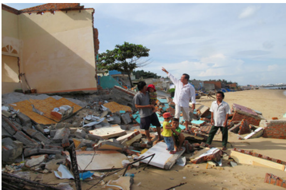
Nhiều căn nhà ở thôn Tiến Đức, xã Tiến Thành bị sập đổ, cuốn trôi vì biển xâm thực.
