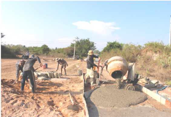
Thi công đường giao thông ở xã Hàm Chính (Hàm Thuận Bắc).
