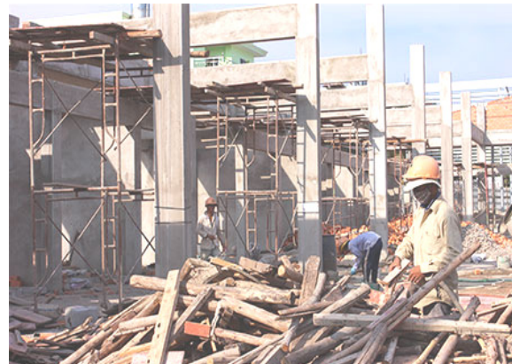
Chợ Mũi Né (phường Mũi Né, TP Phan Thiết) 100% nguồn vốn xây dựng do tư thương đóng góp đang được thi công.
