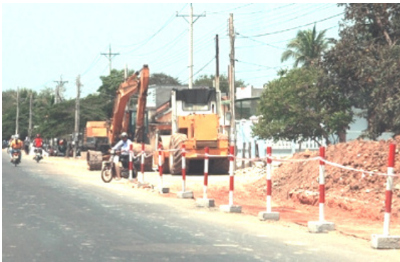
Mặt bằng "sạch" được bàn giao cho chủ đầu tư để tiến hành thi công (đoạn QL 1A qua thị trấn Phú Long).
