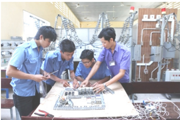
Giờ thực hành của học viên lớp điện - điện tử, Trường cao đẳng nghề tỉnh Bình Thuận.
