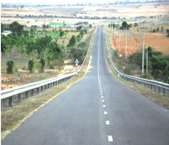
Đường Hòa Thắng - Lương Sơn (tỉnh Bình Thuận). Nguồn: dulichvietnam.com.vn
