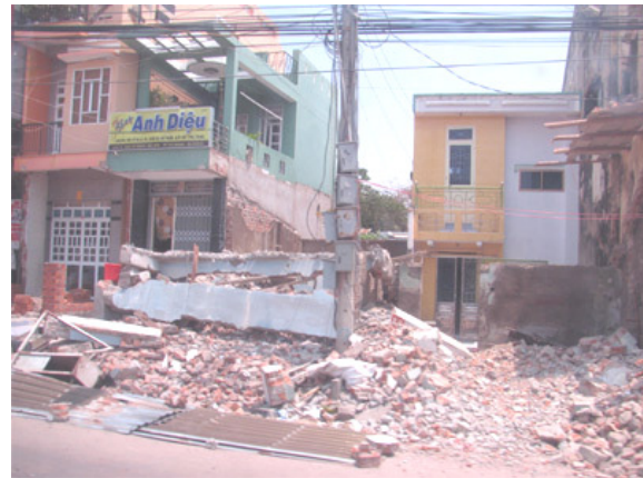
Người dân huyện Bắc Bình (Bình Thuận) tự nguyện phá dỡ nhà cửa phục vụ dự án nâng cấp, cải tạo tuyến Quốc lộ 1A.
