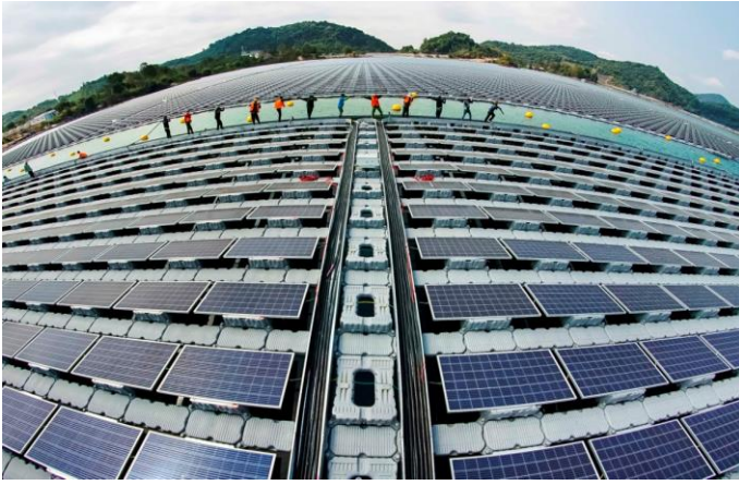
Công trình điện mặt trời trên hồ thủy điện Đa Mi, huyện Hàm Thuận Bắc (Bình Thuận)
