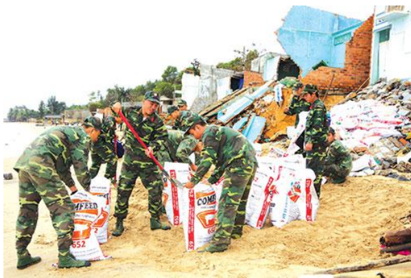
Lực lượng vũ trang tỉnh giúp dân làm kè chống xâm thực ở xã Tiến Thành (TP. Phan Thiết).
