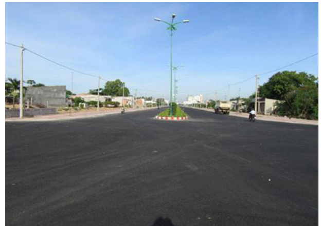
Một góc đường Lê Duẩn (TP. Phan Thiết) trong giai đoạn hoàn thành thi công.
