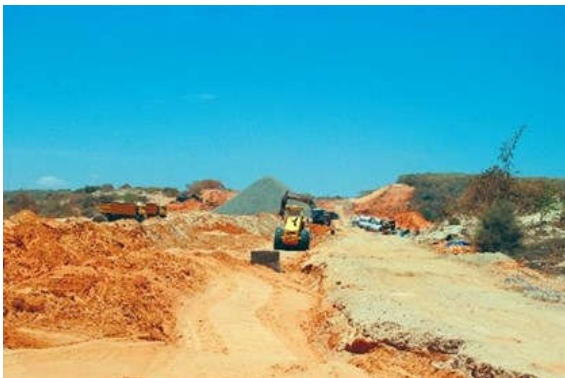
Dự án đường trục ven biển Hòa Thắng - Hòa Phú
