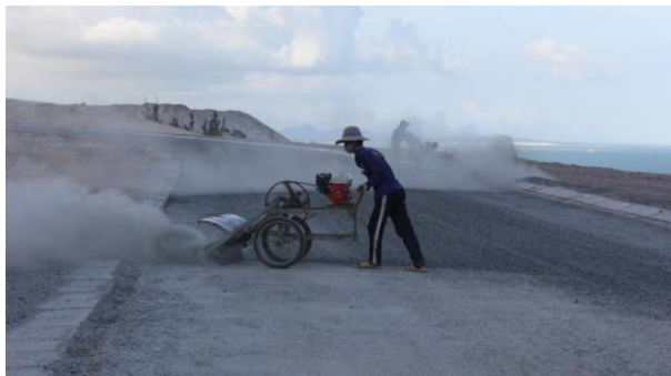
Công nhân làm vệ sinh mặt đường để thảm nhựa.
