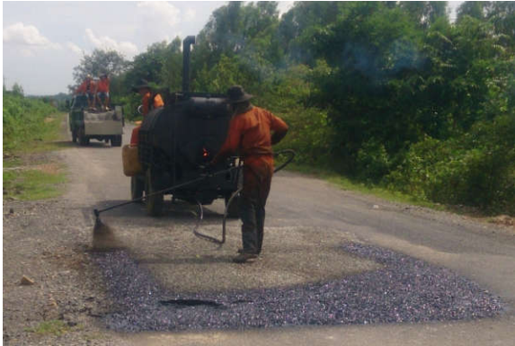
Thi công sửa chữa QL28B đoạn qua Bình Thuận.
