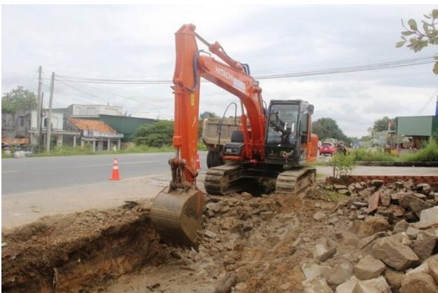
Thi công hệ thống thoát nước trên tuyến QL1 qua Bình Thuận.
