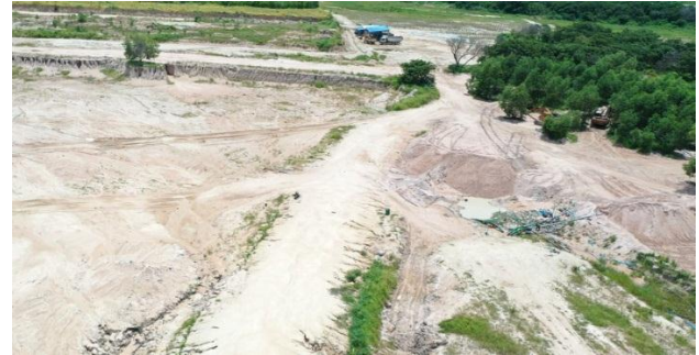
Đại công trường khai thác cát với đầy đủ nhà chòi, xe ben, máy xúc, máy bơm, ống hút (Hàm Tân)
