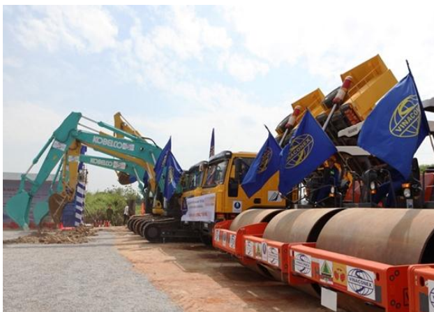
Liên danh nhà thầu tập trung nhân lực, phương tiện, máy móc để triển khai thi công gói thầu XL02, XL04 dự án cao tốc Vĩnh Hảo - Phan Thiết. Ảnh: Trần Hoàng.
