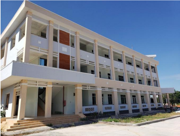
Các hạng mục tại cơ sở 2 đã hoàn thiện, chờ bàn giao Ảnh: Minh Châu
