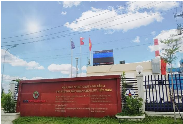
Hình ảnh bảng điện tử hiển thị thông số quan trắc môi trường được gắn tại cổng của Nhà máy Nhiệt điện Vĩnh Tân 4
