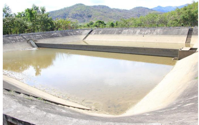
Hồ chứa nước tại nhà máy nước Sơn Lâm, huyện Bắc Bình.
