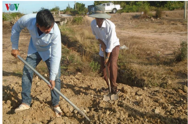
Công nhân công ty TNHH MTV Khai thác Công trình thủy lợi Bình Thuận đang lắp đất để ngăn người dân trộm nước từ kênh N33 chuyển nước từ kênh chính Sông Quao về Nhà máy nước Phan Thiết..
