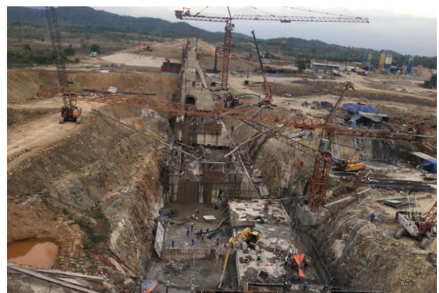
Công trình hồ chứa Sông Lũy thi công 3 ca, bảo đảm hoàn thành trước 31/12/2020. Ảnh: Ngân Phố.
