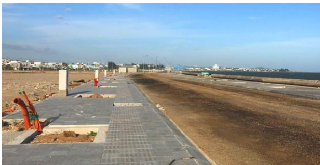
Hạ tầng ven biển dự án Hamubay Phan Thiết đang được thi công.
