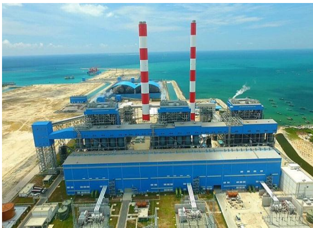
Nhà máy nhiệt điện Vĩnh Tân 4 có công suất 1.200 MW được khánh thành vào ngày 21/9/2019, đơn vị có đóng góp rất lớn vào giá trị tăng thêm của ngành trong kế hoạch năm 2020
