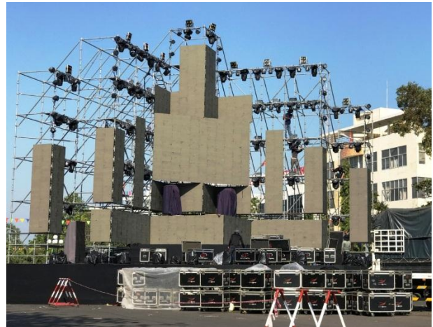
Sân khấu đang được thi công
