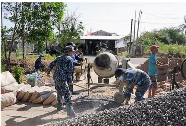
Đổ bê tông xây dựng công trình “ Cổng trường an toàn giao thông ”.
