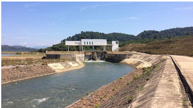
Gói thầu số 28KN thuộc Dự án Hệ thống thủy lợi Tà Pao, tỉnh Bình Thuận có giá trúng thầu hơn 84 tỷ đồng. Ảnh: Đức Linh
