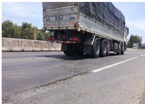
Nhiều đoạn đã bị bong tróc hết phần nhựa đường.
