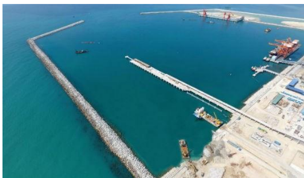
Cảng than đã sẵn sàng để lắp dựng, hiện đang chờ nạo vét
