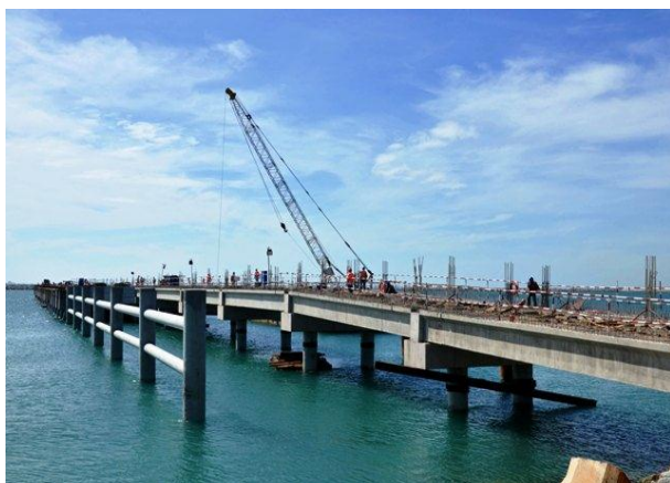
Cầu cảng nhập than Nhà máy Nhiệt điện Vĩnh Tân 1 đang được xây dựng.
