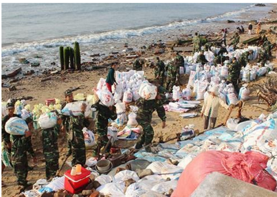
Cán bộ, chiến sĩ Bộ CHQS tỉnh Bình Thuận giúp dân thôn Tiến Đức, xã Tiến Thành, TP Phan Thiết đắp kè chống biển xâm thực.
