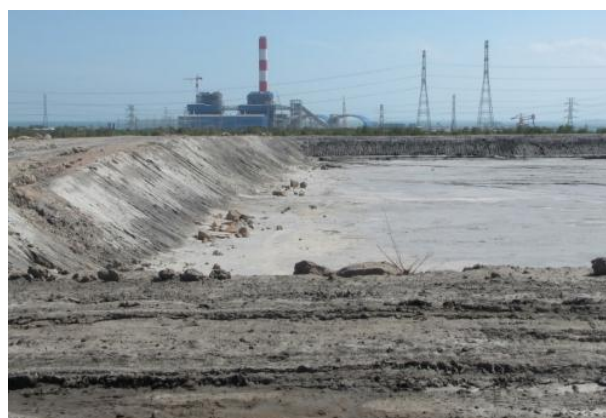
Bãi thải xỉ than nhà máy Nhiệt điện Vĩnh Tân 2, nơi xảy ra sự cố.
