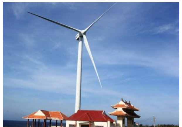
Trạm điện gió đồ sộ trên đảo, cung cấp điện sinh hoạt cho người dân đảo.
