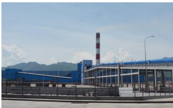
Nhà máy nhiệt điện Vĩnh Tân 2
