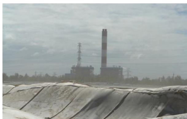
Bãi chứa xỉ của nhà máy điện
