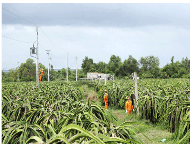
Nhân viên điện lực kéo dây vào vườn thanh long cho hộ trồng thanh long ở Bình Thuận. Ảnh: H.P
