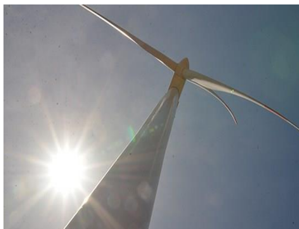
Sau đấu thầu công khai, HydroChina được chọn là tổng thầu EPC, Tập đoàn Vestas (Đan Mạch) cung cấp các tua-bin. Mỗi cột tháp cao 90 mét, mỗi cánh có chiều dài 50 mét. Trọng lượng các thiết bị của máy lên đến 500 tấn.
