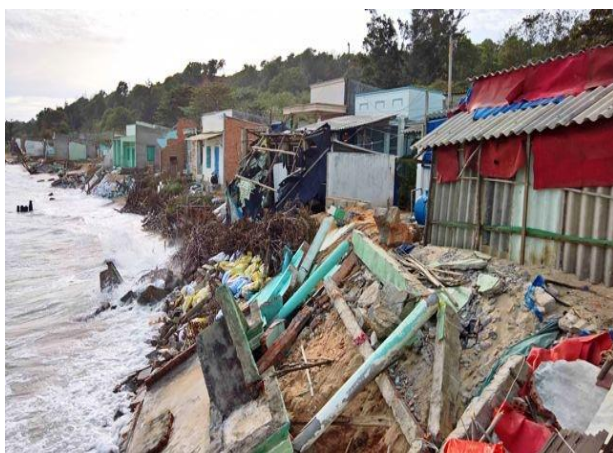
Hơn 1.000 m bờ biển thôn Tiến Đức, xã Tiến Thành, TP Phan Thiết bị sạt lở làm sập năm căn nhà, 34 hộ bị ảnh hưởng
