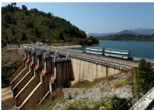
Đập chính và hồ chứa nước nhà máy thủy điện Hàm Thuận. Ảnh: Ngọc Hà/TTXVN
