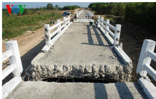
Công trình khắc phục chậm tiến độ so với yêu cầu của UBND tỉnh Bình Thuận
