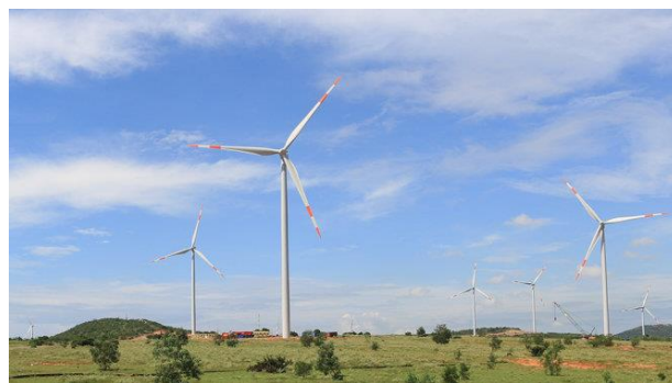
Các cột phong điện Nhà máy điện gió Phú Lạc
