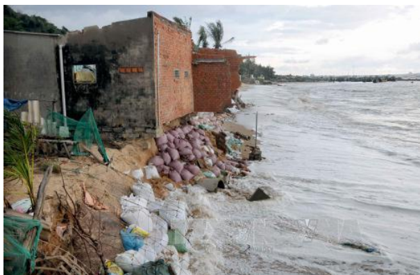
Những đoạn kè tạm được tại thôn Tiến Đức, xã Tiến Thành, thành phố Phan Thiết, Tỉnh Bình Thuận Ảnh: An Hiếu/TTXVN
