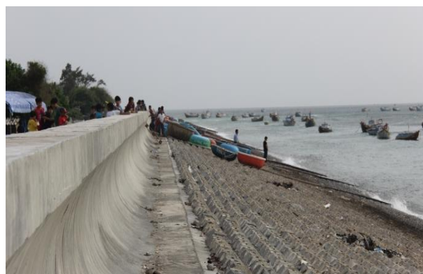
Bờ kè được xây dựng nhiều tỷ đồng để chống lại sự xâm nhập của nước biển trên đảo.
