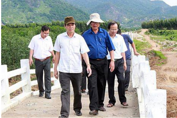
Ông Nguyễn Đức Hòa (áo trắng) cùng đoàn công tác kiểm tra vị trí cầu máng bị đổ sập, hư hỏng
