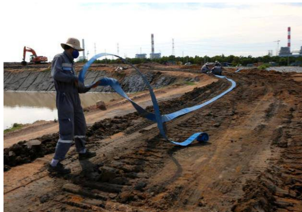
Lắp đặt hệ thống phun nước chống bụi tại khu vực chứa xỉ thải của nhà máy nhiệt điện Vĩnh Tân.
