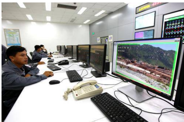
Hình ảnh và các thông số quan trắc từ khu vực bãi thải được truyền về trung tâm điều khiển nhà máy nhiệt điện Vĩnh Tân.
