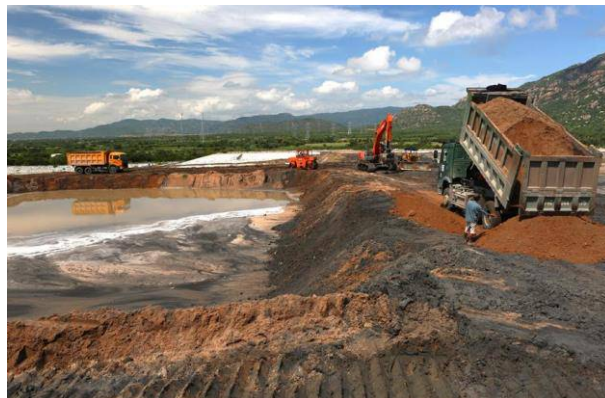
Bãi thải xỉ của nhà máy nhiệt điện Vĩnh Tân.
