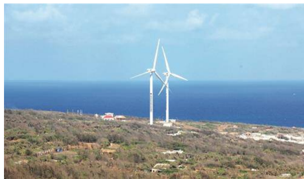
Hệ thống điện gió đã góp phần giải quyết tình trạng thiếu điện sinh hoạt trên đảo Phú Quý
