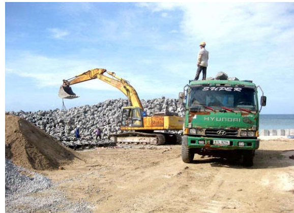
Gấp rút xây dựng hệ thống kè biển trên đảo Phú Quý.
