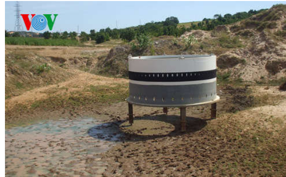
Dự án điện gió Thuận Nhiên Phong (tại xã Hòa Thắng, huyện Bắc Bình) tạm ngừng thi công vì chưa thu xếp được nguồn vốn
